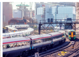
轨道车辆和基础设施
